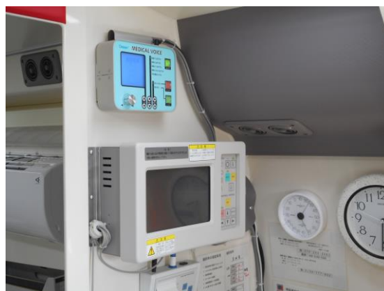
機器操作パネル
